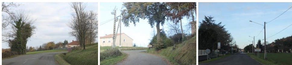
Entrées « de villes » peu qualitatives : manque de lisibilité du tissu ancien et d'intégration du tissu récent (Senac, Mingot, Montégut). Source : EVEN
