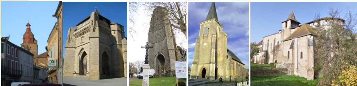
Eglises protégées du territoire : Aignan, Beaumarché, Bernède, Lembeye, St Sever de Rustan. Sources : EVEN, Google Maps
